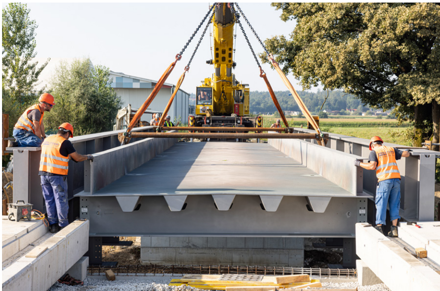
Arbeiten an der Kainachbrücke © Foto Karl Heinz Ferk
