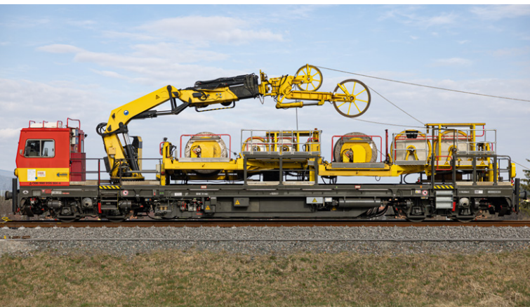
Ziehen der neuen Oberleitung © Foto Karl Heinz Ferk
