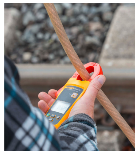
Hochspannungsprüfung © Foto Karl Heinz Ferk
